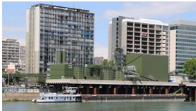
Figure 16 : Centre de tri des déblais de la gare EOLE à la Défense implanté sur la Seine à Courbevoie (92) (source : VNF)
