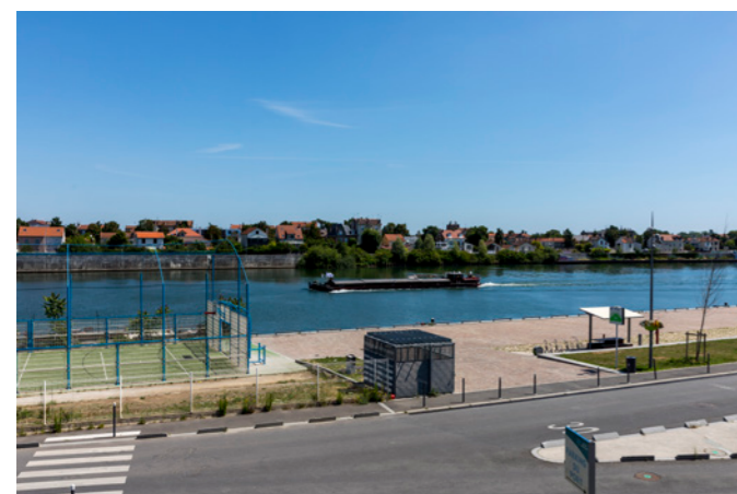
Figure 12 : Port de Choisy le Roi - quai à usage partagé (source : crédit : HAROPA PORT / Laurent Guichardon)
