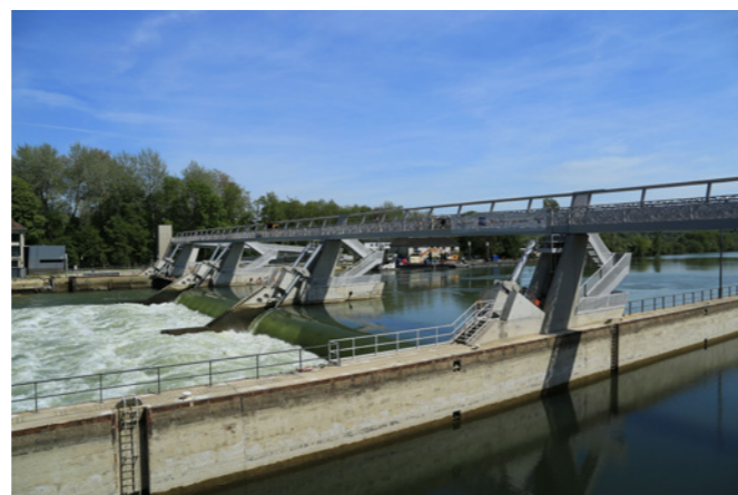
Figure 8 : Barrage de Vives-Eaux (source : VNF)
