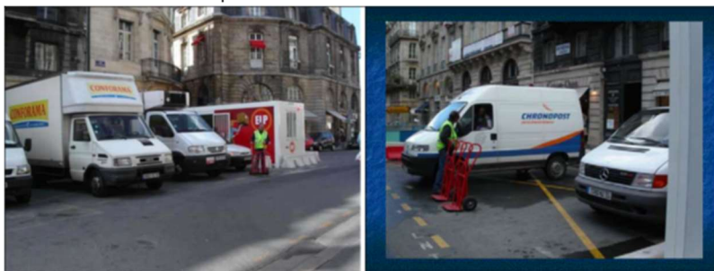
Exemple de points d'accueil véhicules mis en œuvre à Bordeaux lors d'un chantier de voirie. Ces points étaient gardiennés et disposaient d'engins de manutention.
