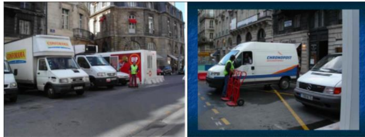
Exemple de points d'accueil véhicules mis en œuvre à Bordeaux lors d'un chantier de voirie. Ces points étaient gardiennés et disposaient d'engins de manutention. Crédit photo - CCI de Bordeaux
